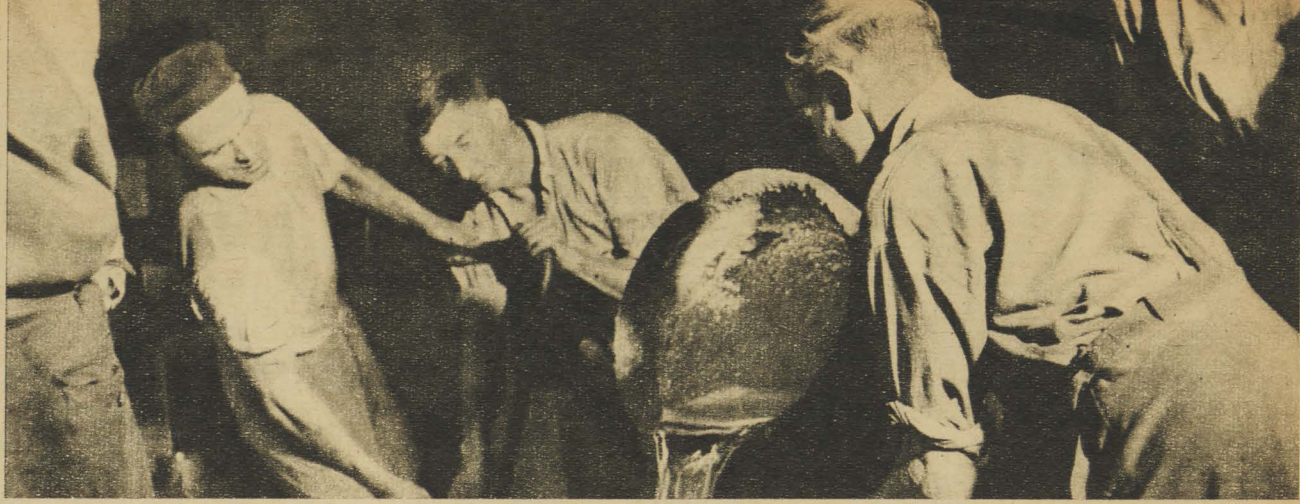
Οἱ ἐργάται ἐπιδίδονται στὸ ἔργο μετὰ τὴν μεγαλύτερη στοργήν.
