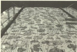
21. Φιγούρες από τις ελληνικές παραδόσεις στον Ευλότυπο, πριν γυθί το μπετόν. Το χταπόδι της Κνωσσού, τα δελφινία της Τριονιάς, ο θυλακτινός άετός, η γοργόνα του Μεγαλέξαντρου, το λαϊκό παραδί, φιγούρες του Καραγκιόζη από τον Ειγέτιο Σπαθάρη. Οι υπόλοιπες φιγούρες και η γενική τοποθέτηση από την γλύπτρια Αθηνά Κ. Τάχα.
