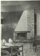
15. Η γωνιά του τζακιού στο εστιατόριο εδωρομένων. Τζάκι γωνιακό με κούνα' καμινάδα από λιθοβολή ανεπύχιστη, ποδιά ξύλινη, φούσκα επιχρισμένη. Τίτλος με επένδυση από καρδιά ραμπότι. Έπιπλα από δρύσι φυσικό χρώμα.
