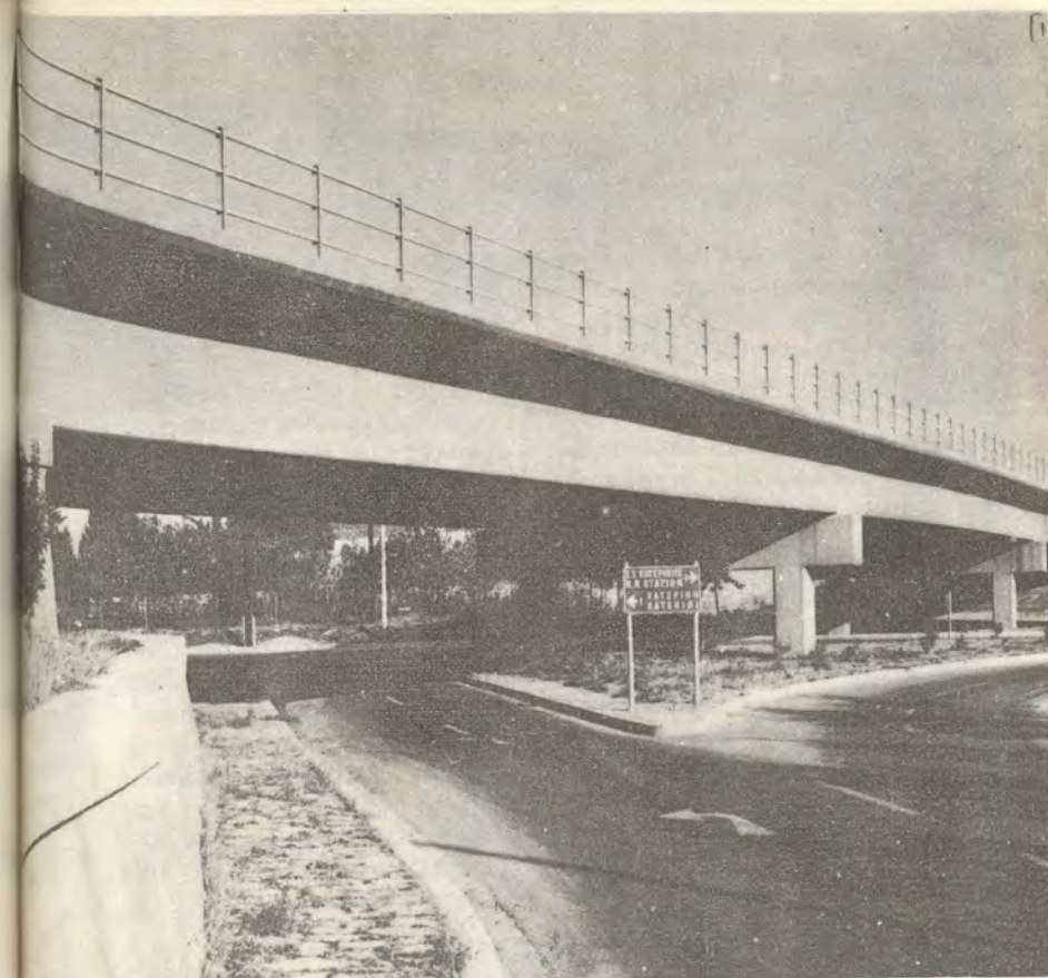
Ὁδικὴ γέφυρα παρὰ τὴν Κατερίνην
