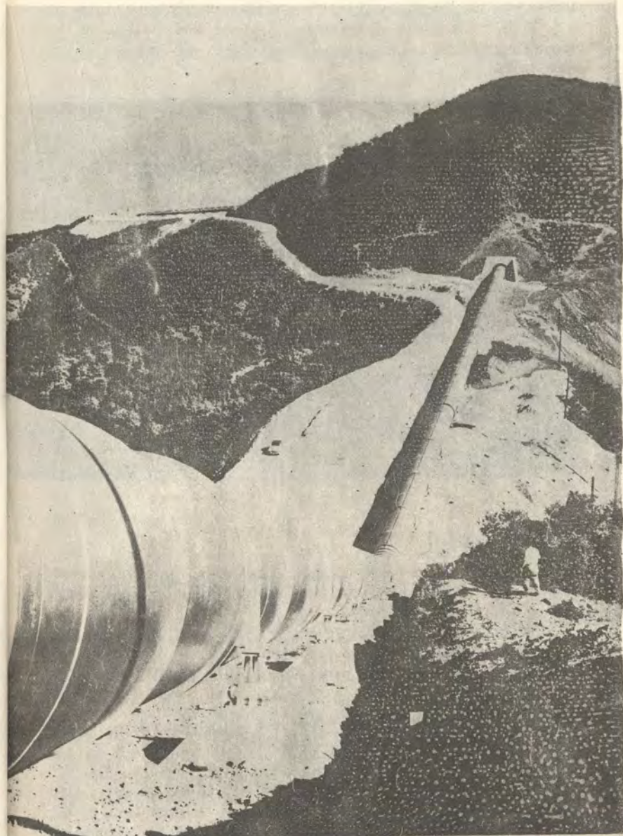
Ἀγωγὸς Ὑδροηλεκτρικοῦ Σταθμοῦ Ταυρωποῦ
