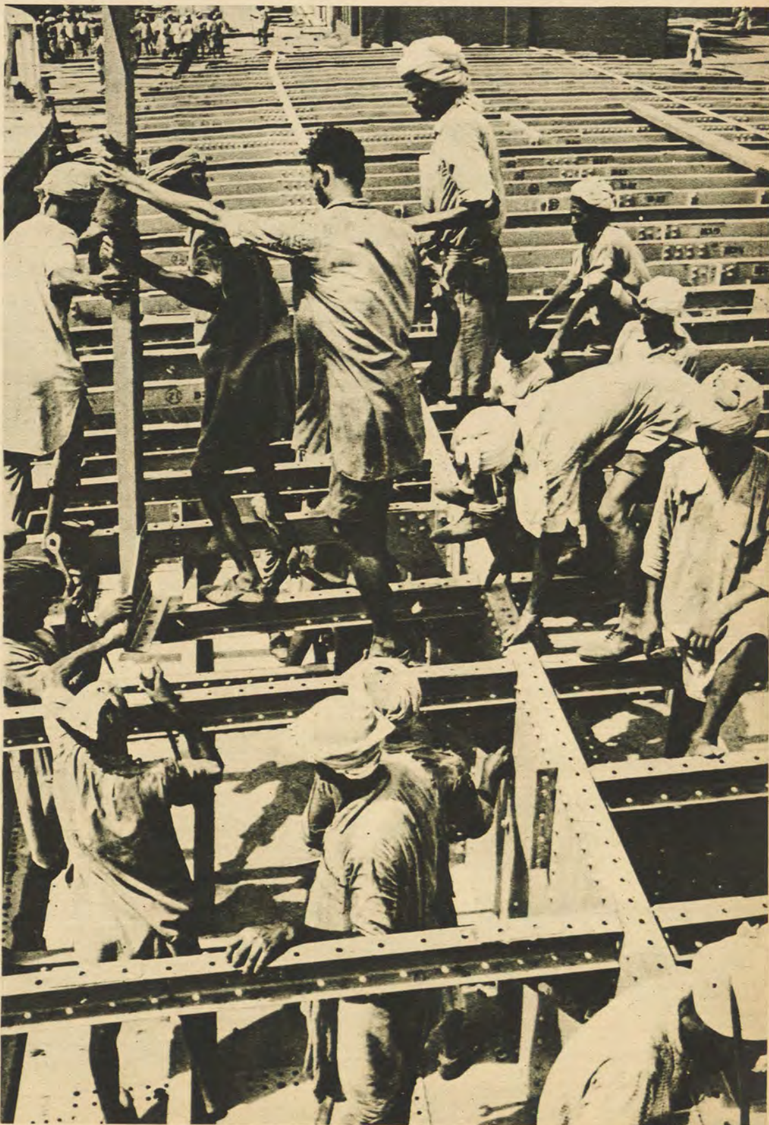
Πολεμικὸν πλοῖον ὑπὸ κατασκευὴν εἰς ἕν Ἰνδικὸν Ναυπηγεῖον.
